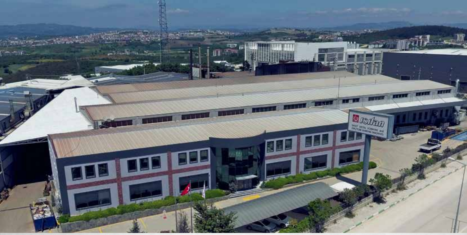
ANA ÜRETİM TESİSİ / MAIN PRODUCTION PLANT- 11.000 m 2
